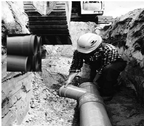
Fig No 2. Tubería de PVC
