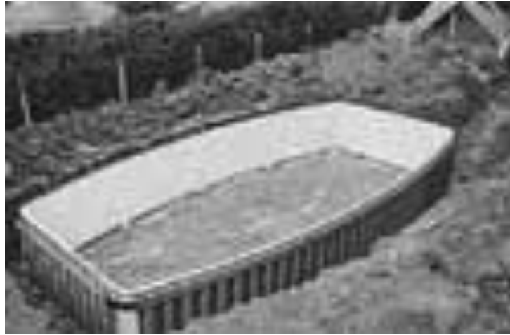
Fig No1. Encofrado de polipropileno para una piscina
