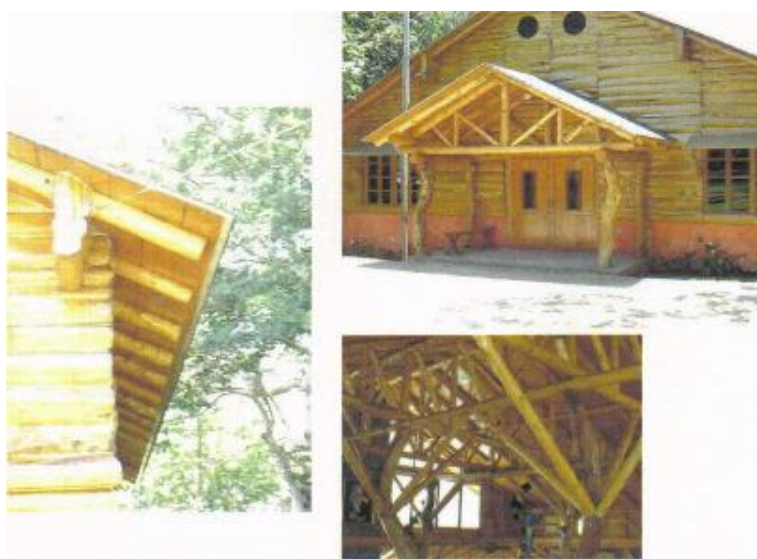
Hotel Santa Leticia, Apaneca. Ahuachapan, Cubierta de viguetas y cubierta de tijeras
