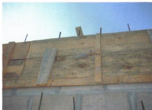
Enconfrados utilizando madera Tomada en Residencial Montecarlo, tomada 25 de junio del 2006
