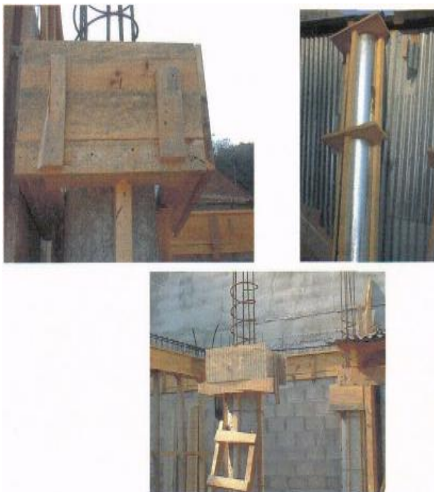
Fotografía tomada el domingo 25 de junio de 2006 en Cumbres de Cuscatlán, sobre el levantamiento de paredes de vivienda
