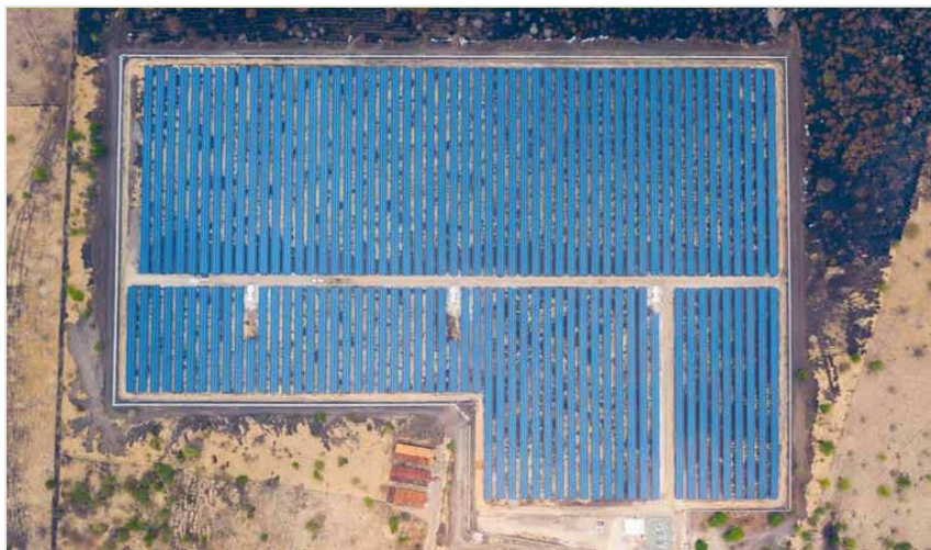
Figura 2-16. Planta Solar Fotovoltaica de Pasaquina en El Salvador
